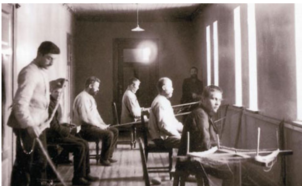
Knoping av lineangler og binding av fiskegarn.
